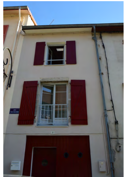
Façade après travaux
