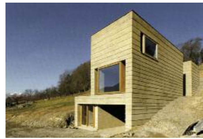
Une maison en pisé et encadrements d'ouvertures en bois, adaptée à la pente du terrain.
