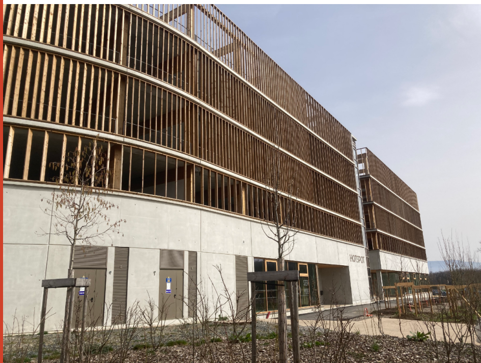
Parking silo Hotspot - © CAUE de l'Ain
