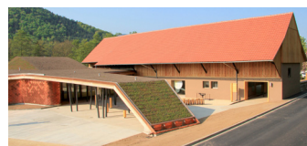
GUNSBACH – Maison du Munster : © DWPA Architectes, Maison du Fromage
