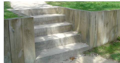
Escaliers incorporés dans un soutènement en bois
