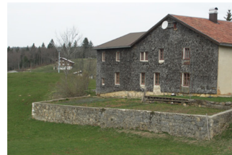
Terrasse potagère soutenue par un mur en pierre sèche
