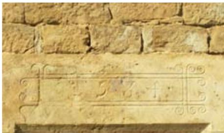
La pierre de taille, non gélive, est taillée en blocs réguliers. Destinée à rester apparente, elle est posée avec soin, à joints vifs, sans mortier ; sa finition est très soignée.
