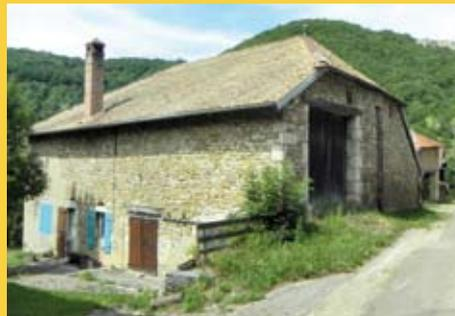
La solution la plus simple est de profiter du relief naturel du terrain et d'adosser la ferme à un repli de terrain. En cas d'impossibilité, on a recours à la levée ou au pont de grange.
