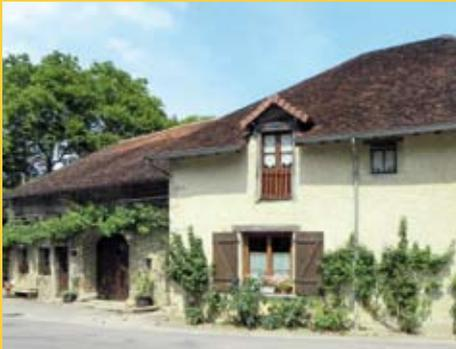
La lucarne, unique et étroite, est en continuité avec la façade et interrompt la partie basse de la toiture et la gouttière. La lucarne est une pièce de charpente dont la structure est en bois.
