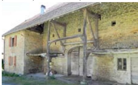
Les galeries assurent des surfaces supplémentaires de stockage abritées par les auvents. Elles sont supportées par des poteaux sur le Plateau et dans le Vignoble, par des consoles en Bresse.
