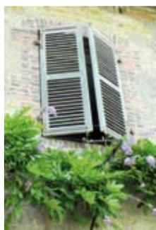
La largeur des ouvertures est conditionnée au système constructif et n'excède pas un mètre. Les encadrements en briques illustrent des constructions ou des modifications plus récentes.
