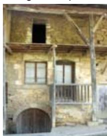
Ce bois est largement protégé de l'humidité dans sa mise en œuvre. Il est abrité par le débord de toit, les poteaux reposent sur des pierres dures les isolant du sol.
