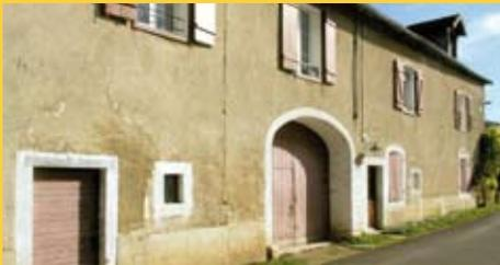
Exceptionnellement, dans le cas de bâti plutôt isolé et sur des façades protégées de la pluie, l'enduit pourra être à « pierres vues ». Cette pratique consiste à compléter les joints par du mortier de chaux d'une couleur proche de la pierre jusqu'au nu approximatif du mur. L'aspect obtenu est celui d'un enduit largement usé, laissant voir la partie saillante des moellons. L'enduit à « pierres vues » est réservé aux façades à l'appareillage de qualité qui n'ont pas subi de transformations.
