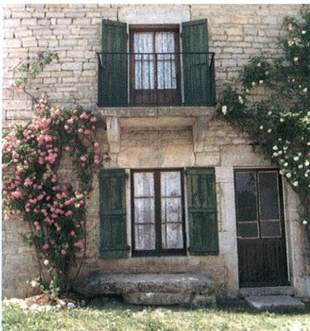
Elles sont plus hautes que larges, à deux battants et six carreaux, les linteaux sont généralement droits, rarement cintrés ou délardés. Les proportions des fenêtres de fermes sont de 2/3 (0.90m x 1.30m), celles des maisons sont proches de 1/2 (0.90m x 1.8m). Lors de la rénovation, elles sont à conserver ; il est possible d'adoindre une seconde baie de dimensions identiques.
