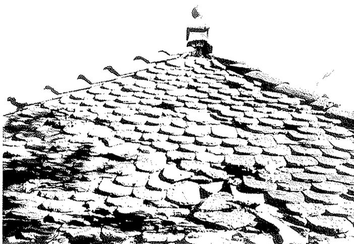
Sur les toits à forte pente, la petite tuile plate ou la tuile écaille remplace, en général, la tuile canal.
