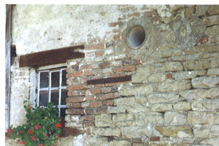
Moellons de pierre, jambages en briques, linteau et allège en bois
