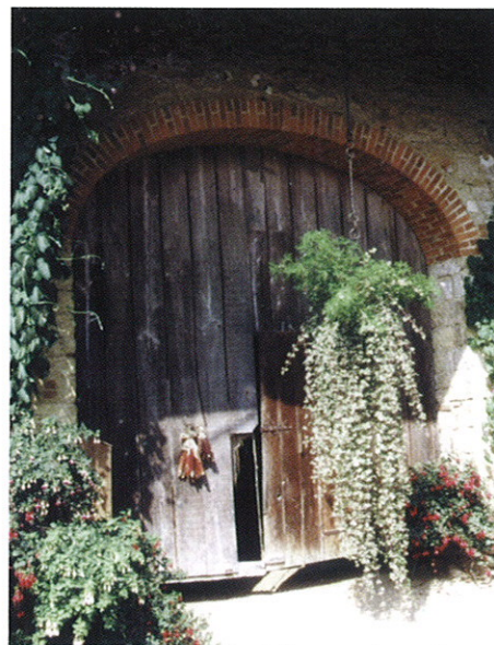
Jambages en pierre de taille, arc de porte en briques.
