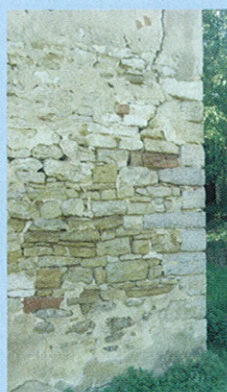
Bouchardage fin qui reste apparent
