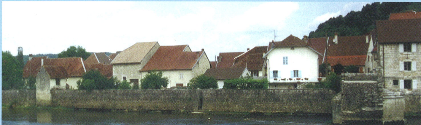
Le recul imposé par la Loue permet d'avoir des vues d'ensemble sur "le Port de Lesney", avec un ensemble bâti formé par les façades, les toitures, l'eau et le végétal.
