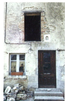
Moellons de pierre avec jambages en briques, linteaux et allèges en bois
