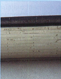
Sous-face de toiture en bois peint
