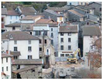
Démolition de l'îlot Gouttefangeas, Olliergues ©Pnr Livradois Forez
