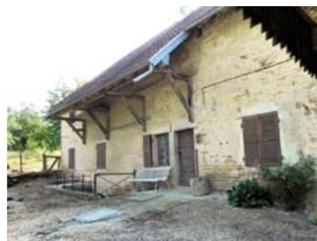
Tout en protégeant à l'extérieur, il doit permettre l'évaporation rapide de la vapeur d'eau contenue dans le mur. L'enduit ciment, qui peut créer des poches d'humidité, est à proscrire au profit d'un enduit à la chaux favorisant les échanges hygrométriques.
