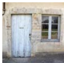
Linteau en accolade.
