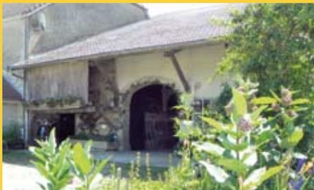
La galerie en façade est une construction en bois, abritée par le large débord de toiture et protégée par les murs pignons. On y stocke le bois de chauffage, qui y sèche lentement et qui est accessible même par mauvais temps. Elle peut être bardée de planches de bois qui protègent de la pluie.
