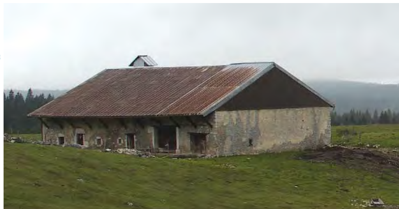
Pignon traditionnel à la Grande Verrière
