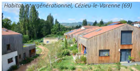
Habitat intergénérationnel, Cézieu-le-Varenne (69)
