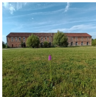
19/10/2024 VISITE Église moderne et rénovation de l'abbaye de Citeaux de 15:00 à 16:30 Sur inscription au 0380613258 Saint-Nicolas-lès-Citeaux Tarifs habituels
