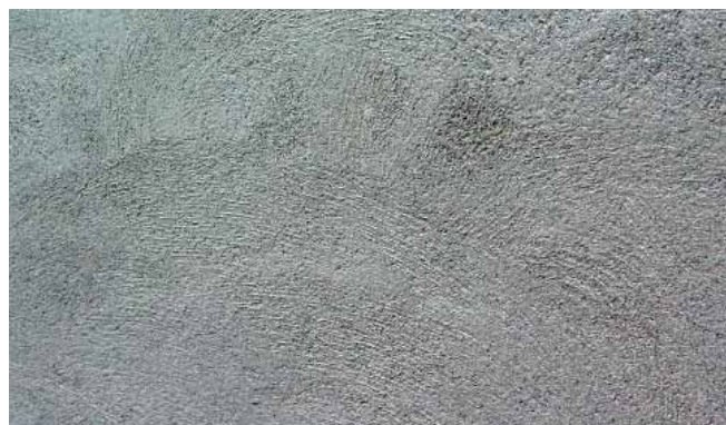
Corps d'enduit (ou dégrossi). Il est chargé d'imperméabiliser le mur tout en rectifiant les inégalités de surface. Agrégat 0-3 mm
