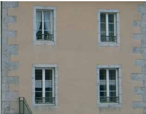
L'enduit met en évidence les chaînages d'angle et les encadrements de baies.
