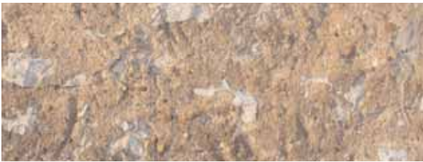
Enduit dit à "pierre vue"
