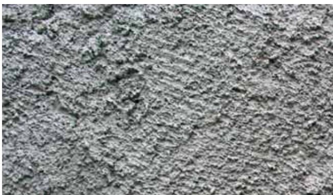
Corps d'enduit (ou dégrossi). Il est chargé d'imperméabiliser le mur tout en rectifiant les inégalités de surface. Agrégat 0-3 mm
