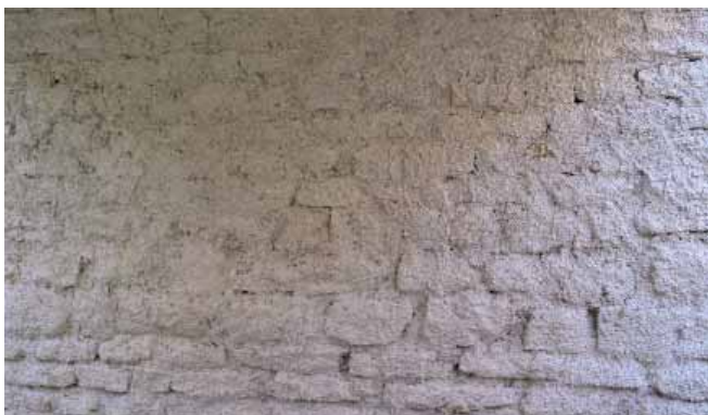
Gobetis. Sous couche d'accrochage sur support en moellons préalablement piqué et nettoyé - Agrégat 0-5 mm
