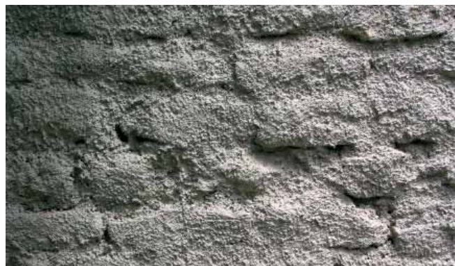
Gobetis. Sous couche d'accrochage sur support en moellons préalablement piqué et nettoyé - Agrégat 0-5 mm
