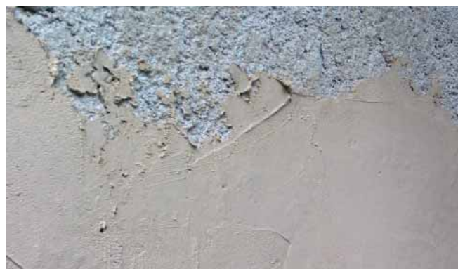
Corps d'enduit (ou dégrossi). Il est chargé d'imperméabiliser le mur tout en rectifiant les inégalités de surface. Agrégat 0-3 mm
