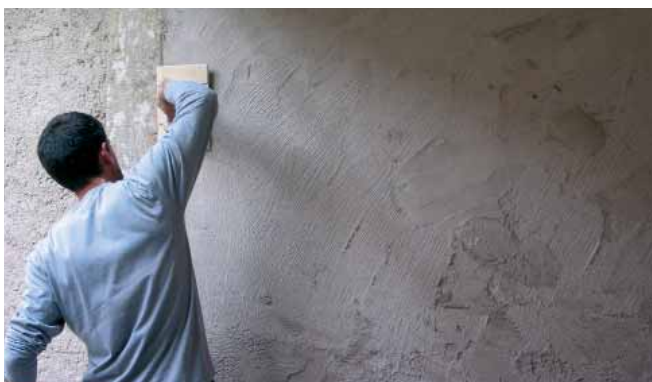
Couche de finition talochée puis lissée. Agrégat 0-2 mm
