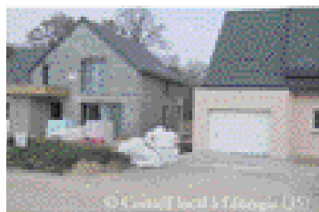
Mise en place d'une charte « Chantiers Propres » (gestion des déchets de chantier par utilisation de « big bags »).
