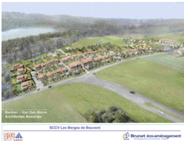
Opération des Berges de Bouvent SCCV Groupe Floriot/Brunet Eco - Aménagement
