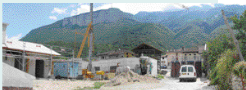
Début de chantier, le nouveau quartier sort de terre après la réalisation des travaux de correction torrentielle sur le ruisseau de l'Echinard.
