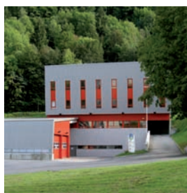
Centre d'incendie et de secours
