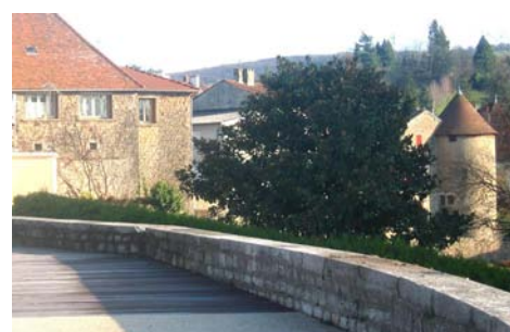
Aménagement du centre bourg
